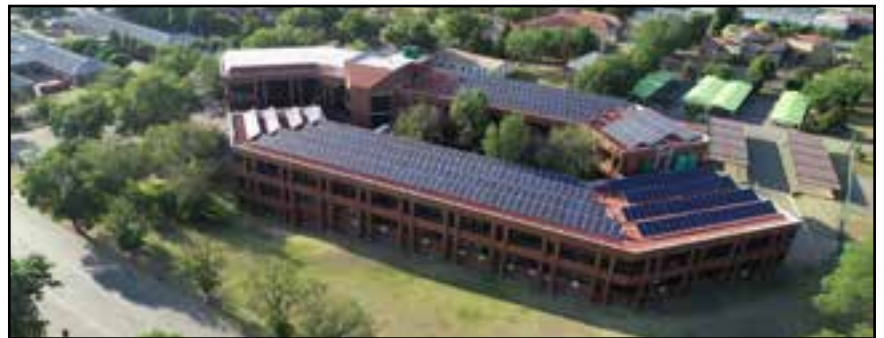
'n Lugfoto van VKB se hoofkantoor op Reitz. Die 417 sonpanele op die dak is in 2016 geïnstalleer om energiekoste en die maatskappy se koolstofvoetspoor te verminder. Met sonkrag kan tot 40% van die gebou se elektrisiteitsbehoefte voorsien word. Die het 'n aansienlike besparing tot gevolg.
