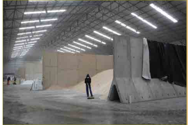
Die aanpasbare Yfel-blokke word gebruik vir die skeiding van verskillende grondstowwe en produkte in groot opbergruimtes.
